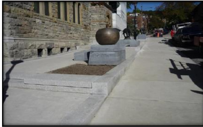
Fig.I.6. Béton pour la construction de trottoirs municipaux.
