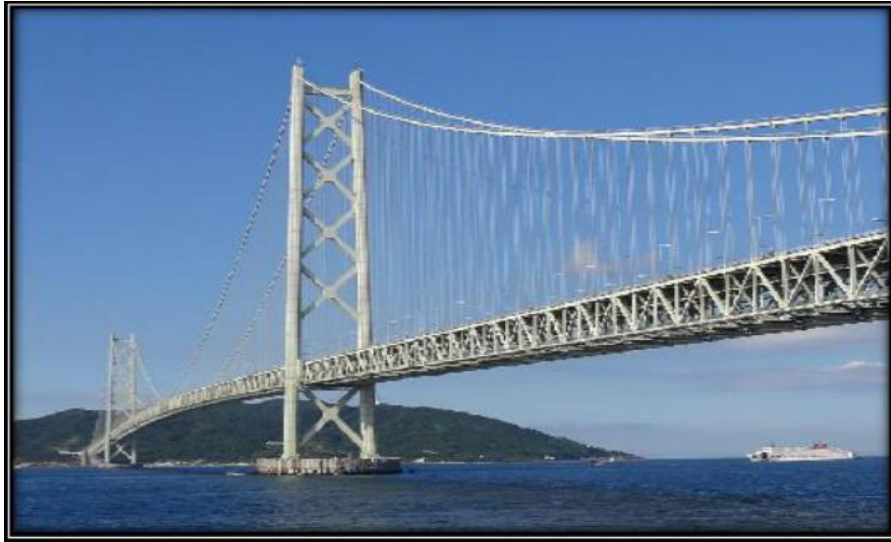
Figure 1.5 : Le pont Akashi Kaikyo.
