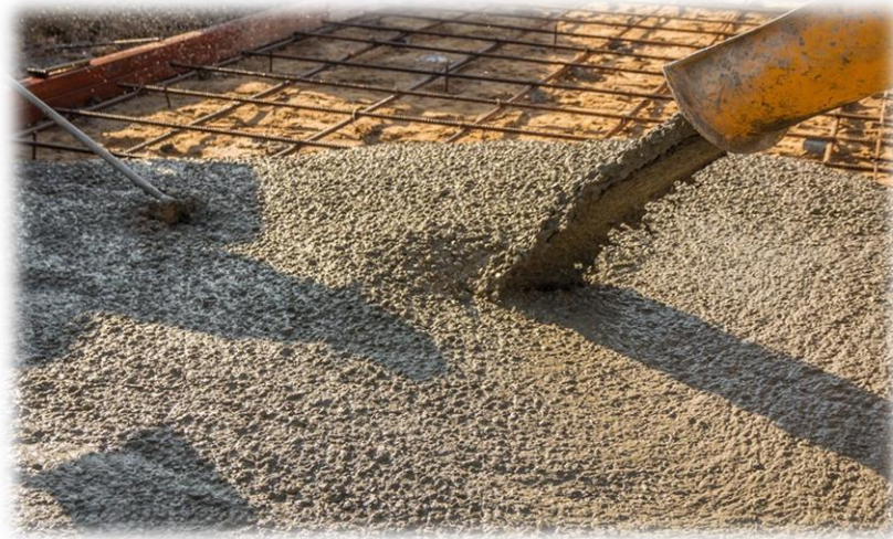
Figure 1.1 : Mise en place d'un béton auto-plaçant (BAP).
