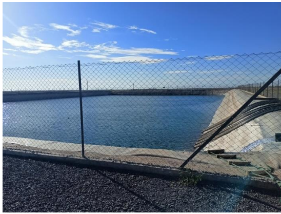
Figure 4.18 : Bassin de stockage d'eau
