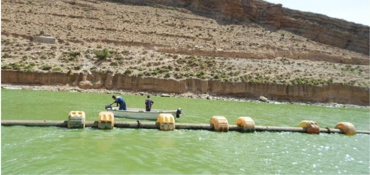
Figure II.28: Conduite flottante [source étudiante].
