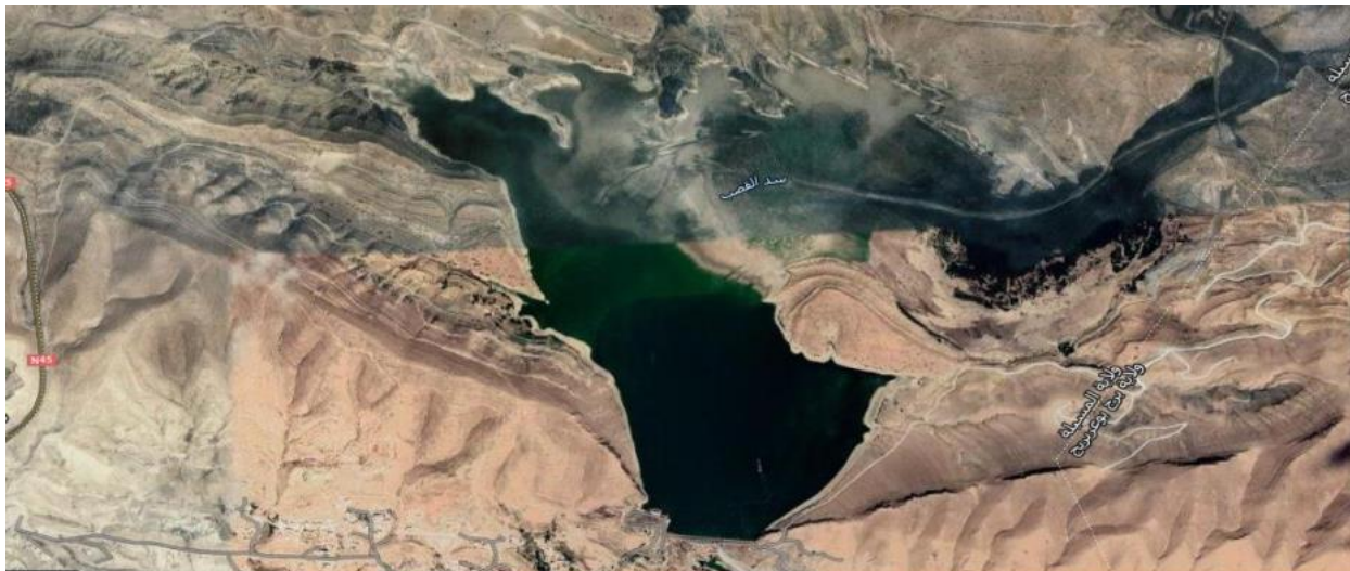
Figure I.3: Vue aérienne du barrage du K'SOB par Google Earth 2022.
