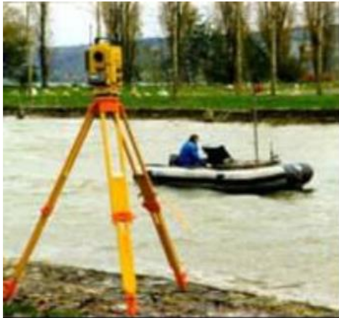
Figure I.14: Estimation de l'envasement par la méthode de nivellement (Tachéomètre).
