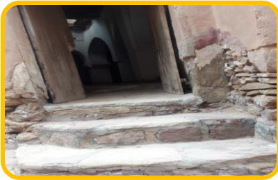
الصورة رقم(28) :المدخل الغربى
