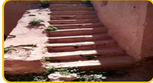
صورة رقم (23):سلم المنزل
