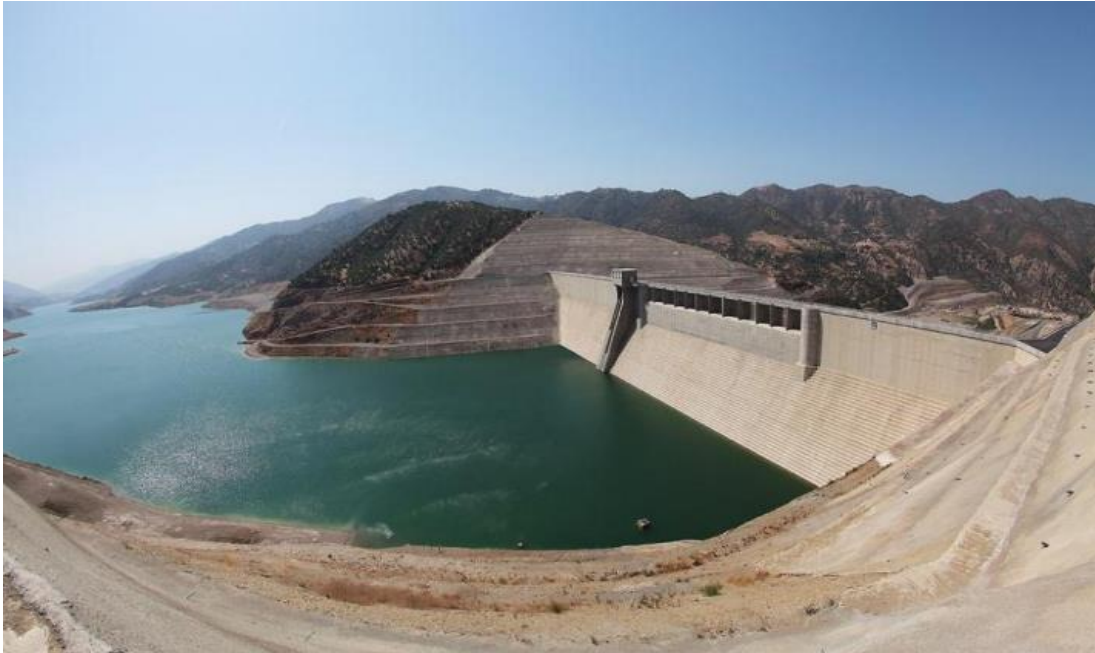
Figure I.7: Barrage en BCR.
