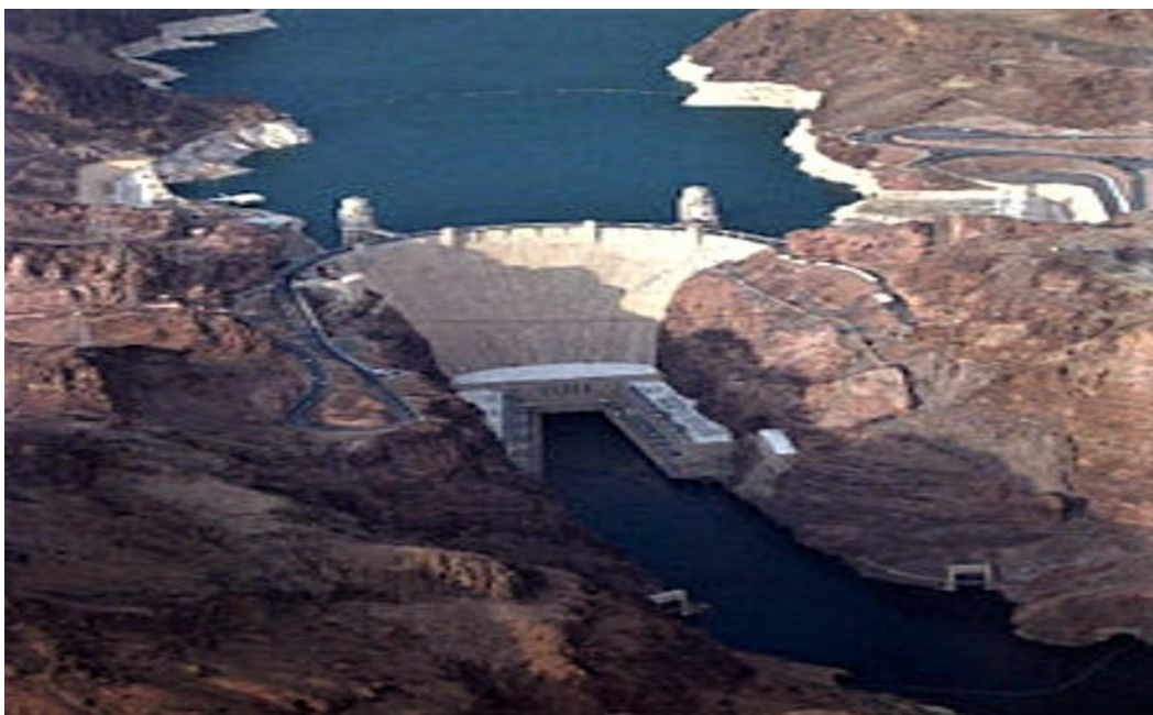
Figure I.4: Barrage Hoover (états –unis).
