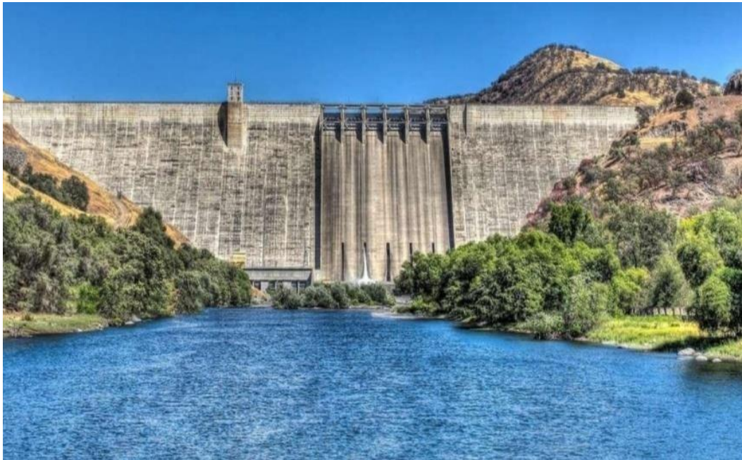
Figure I.1: Le barrage poids de Pine Flat
