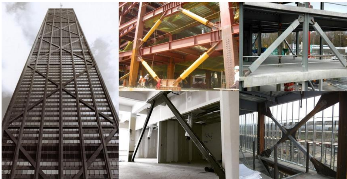
Figure 3.5 Steel bracing [28].
