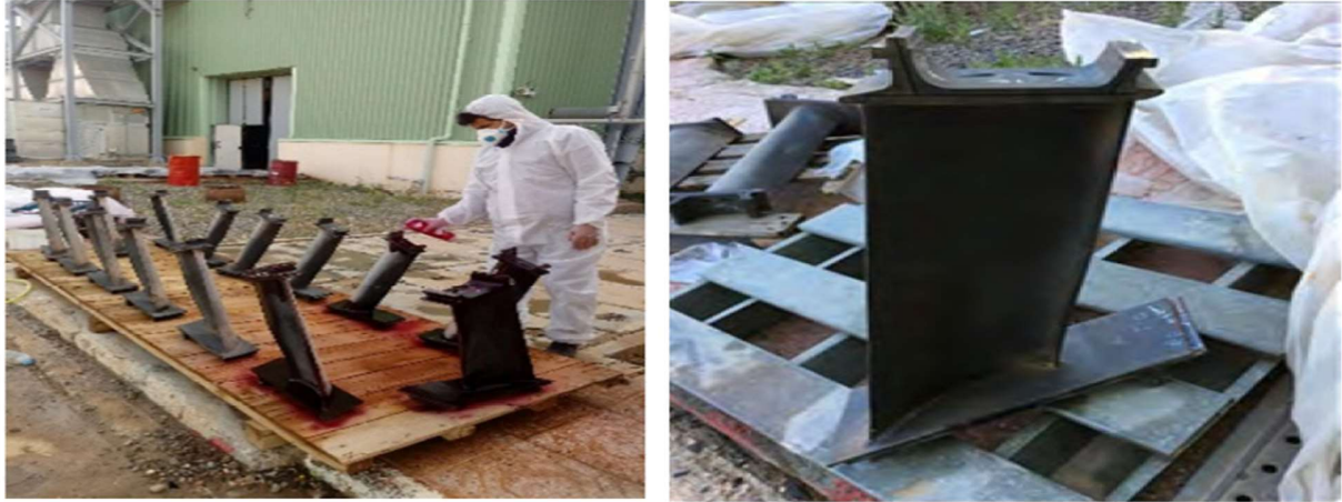
Figure IV-10 Dégradation des aubes fixes.
