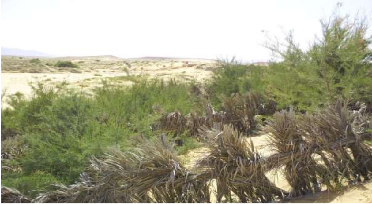
Figure N° 38 : Fixation des dunes par les feuilles de palmiers avec fixation biologique (Houamed a Bou saâda) (Photo personnel)
