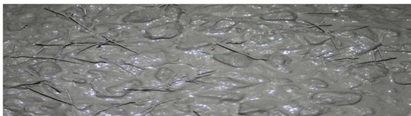
FIGURE I. 5 : TEXTURE D'UN BETON FIBRE [18].
