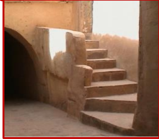
الصورة رقم (27): توضح المدخل الأول
