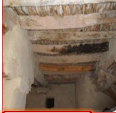
الصورة رقم (37): توضح تسقيف بالخشب
