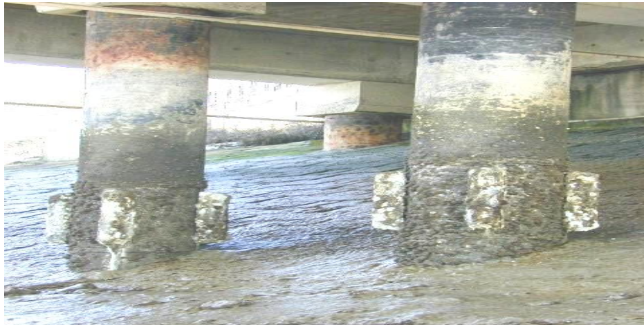
Figure II.4: Des cas pathologiques rencontrés : l'influence des eaux agressifs en contact [1].
