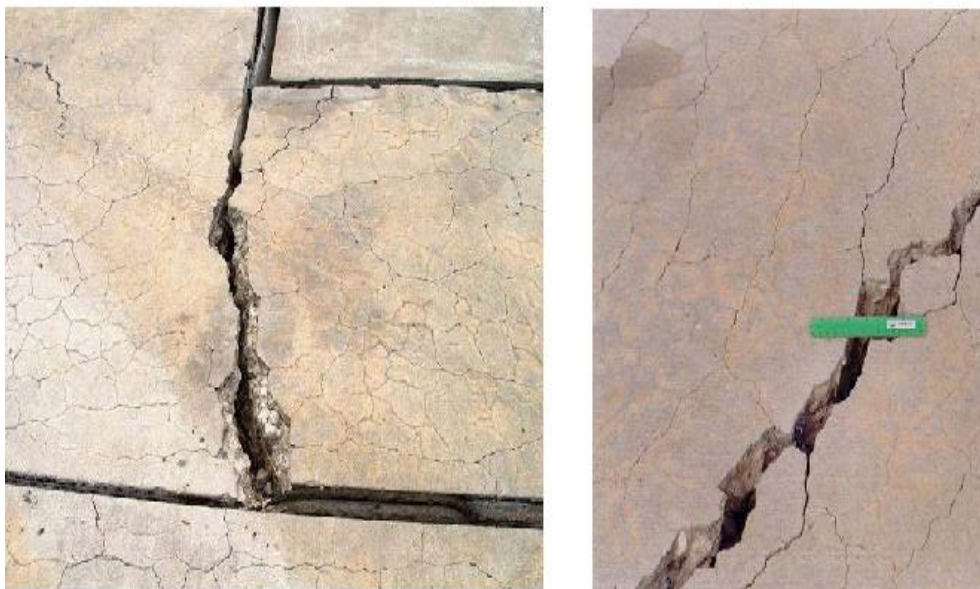
Figure II.13.phénomène d'alcali réaction rencontré. [1]
