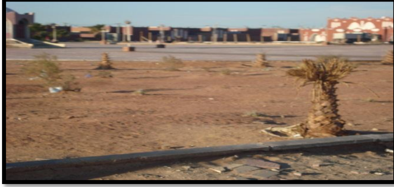
الصورة(20):توضح حالة الاهمال التي تعاني منها المساحات الخضراء من اعداد الطلبة 2014
