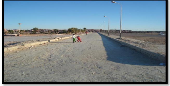
الصورة (22): توضح حالة الطرق في منطقة الدراسة من إعداد الطلبة 2014
