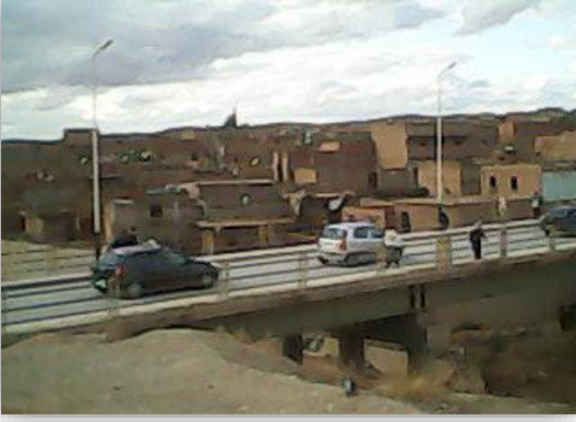
الصورة (13) توضح أحد جسور المدينة جسر القراية
