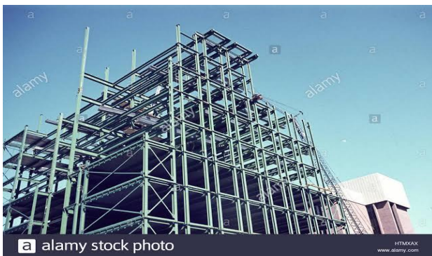
Figure .1.1 : Structure en acier d'un bâtiment en construction. [2]
