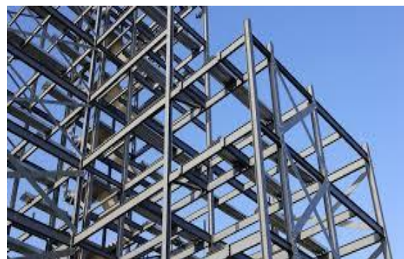
Figure .1.2 : Les poutrelles dans construction en acier. [3]
