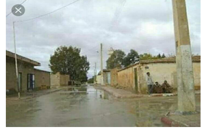
الصورة 08: حالة سيئة
