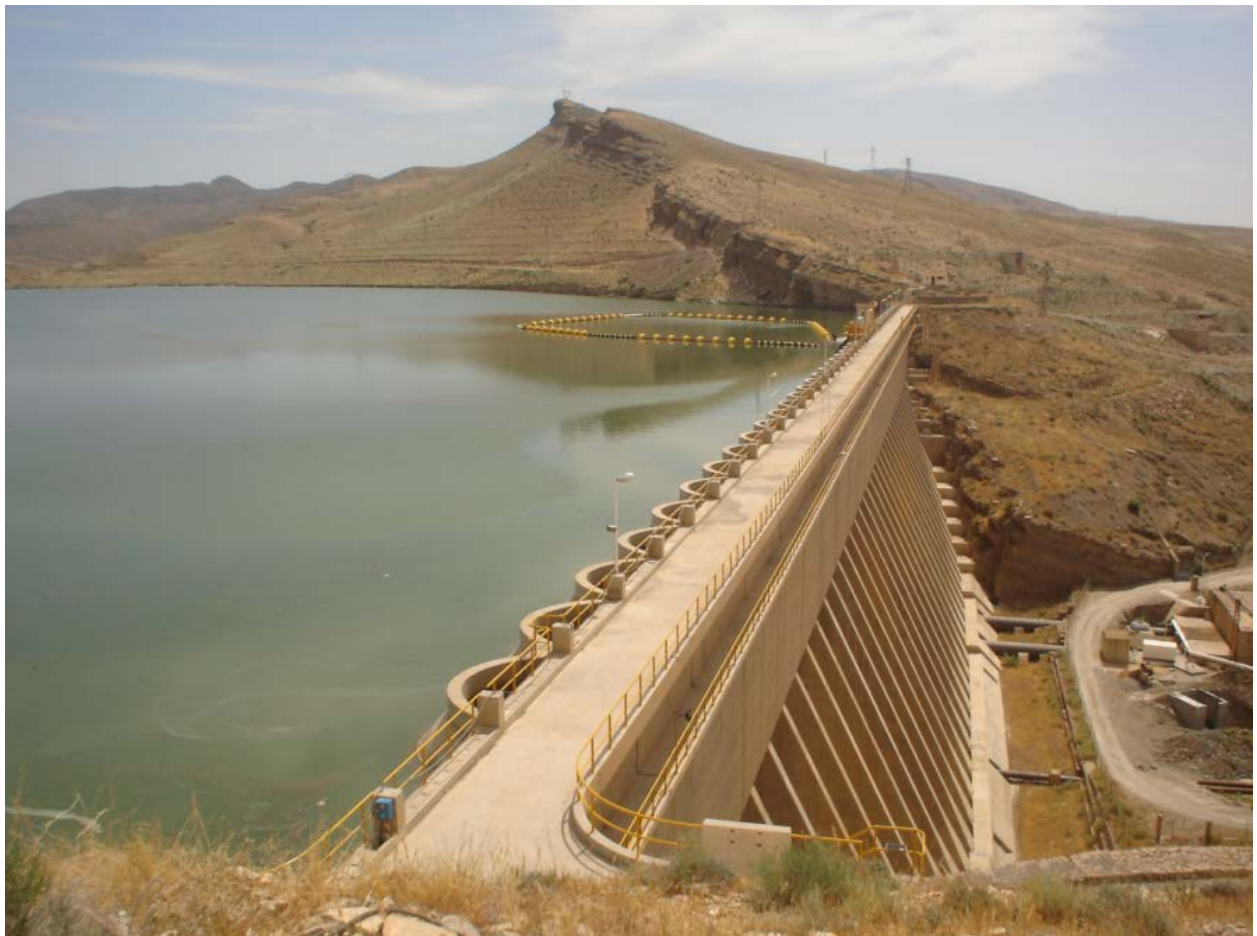
Barrage de K'sob.
