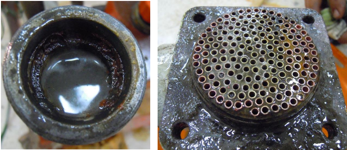
Figure II.52 : Nettoyage de l'échangeur par acide.
