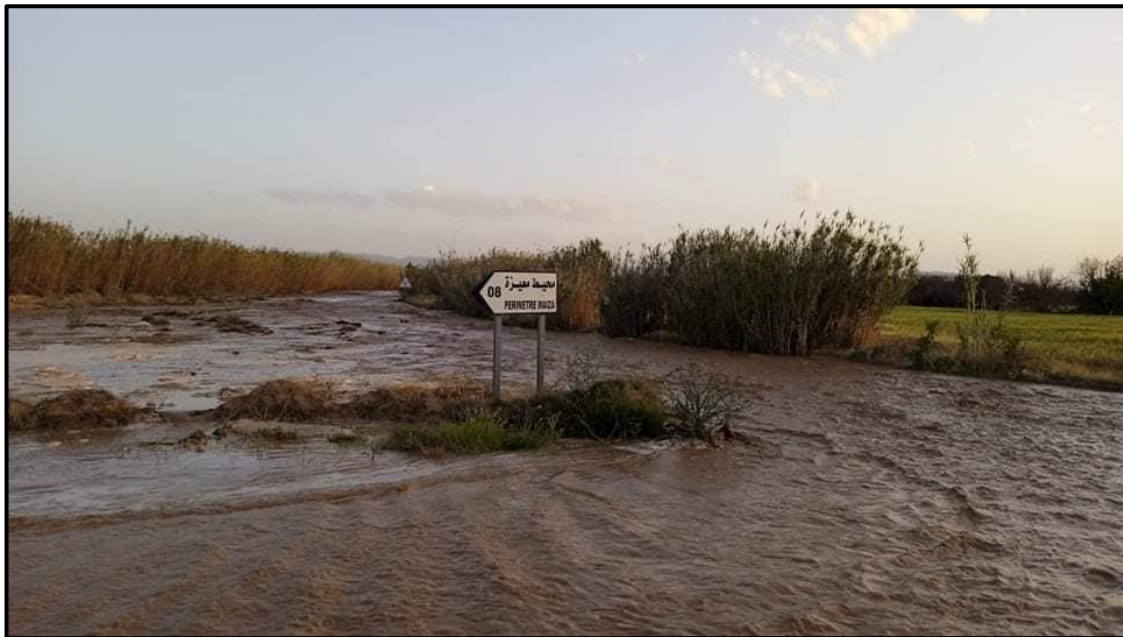
Figure 25 : Des apports alluviaux au périmètre agricole du Maiza Commune de Houamed (avril 2022)
