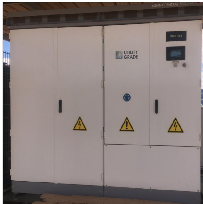
Figure II.5: Armoire de l'onduleur de type Sunny Central 880CP XT.
