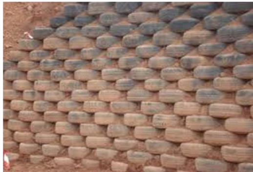
Figure .I.13 : Ouvrage en Pneusol
