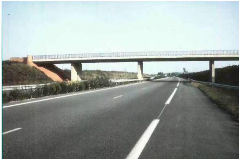
Figure II.5.2-1 : Photo d'un pont dalle
