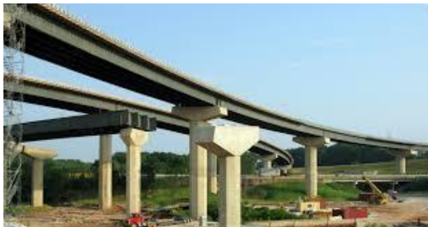
Figure II.5.3-1 : Photo d'un pont mixte
