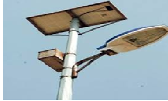
الصورة: (19)، (20) أعمدة كهربائية تعتمد على الطاقة الشمسية
