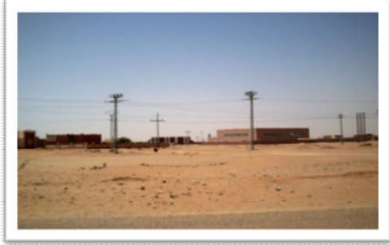
الصورة رقم (11): تبعثر شبكة الأسلاك الكهربائية
