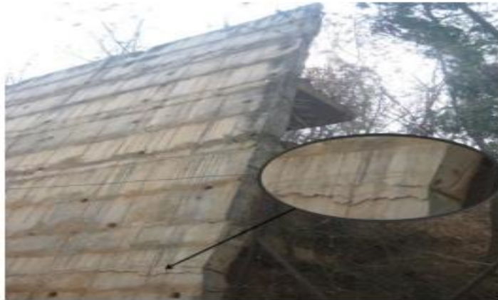
Figure I.15: Mur de soutènement cantilever avec des étagères de soulagement à Hyderabad, en Inde.
