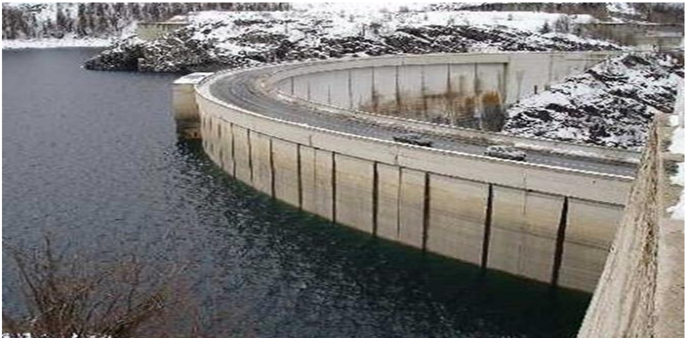
Photo I.2: Barrage-voûte de Tignes–Savoie, France- (photo B. Julliard); véritable arc cylindrique de 150 m de rayon et de 295,5 m de développement.
