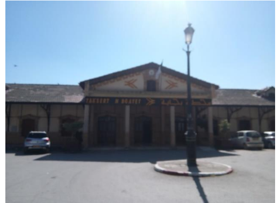
Photo n° 25 :la gare ferroviaire.
