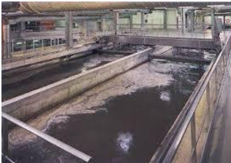
Figure 3 : Dessableur-dégraisseur rectangulaire
