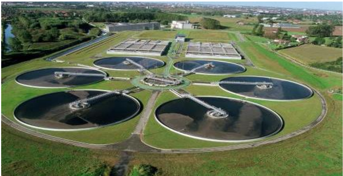
Figure 1: Vue aérienne d'une station d'épuration
