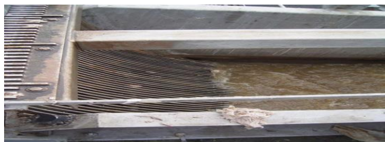
Figure 2 : Lamelles de dégrillage
