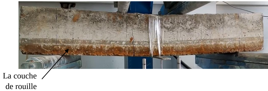
Figure (V-14) : Mode de rupture des poutres préfissurées/corrodées
