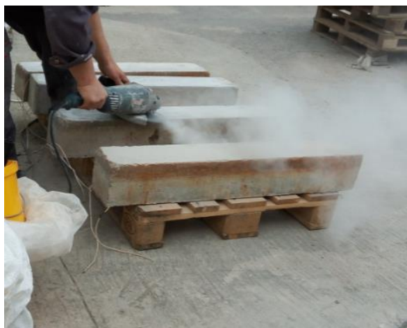
a : Préparation de surface par ponçage
