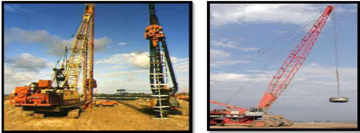
Figure I-14 : Compactage par vibro-sonde.
