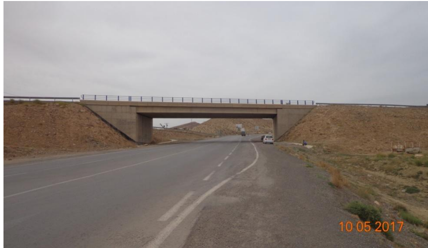
d)-Pont de l'échangeur RN45 PK :31+535
