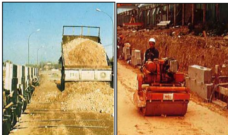
Figure II.14. - Exécution des remblais et du compactage.
