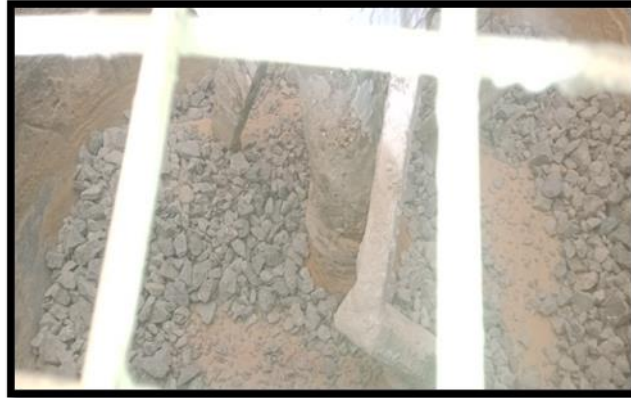
Figure III.7. Malaxage du béton ordinaire
