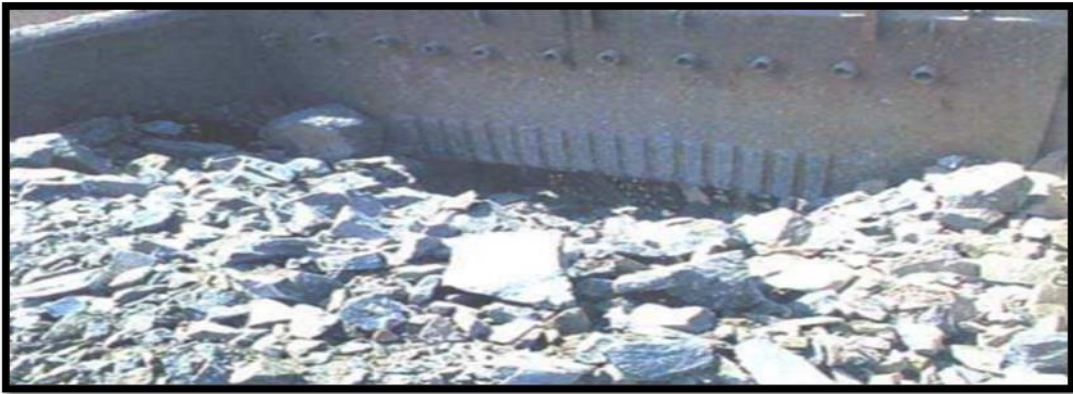
Figure.I.4.Opération de concassage.
