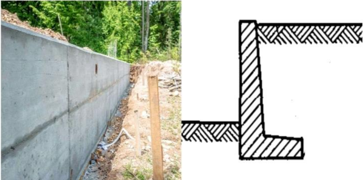
Figure I.2: Exemple de mur poids en béton.
