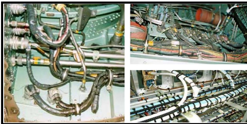
Figure 1.8: Exemple de câblage dans le domaine aéronautique [8].
