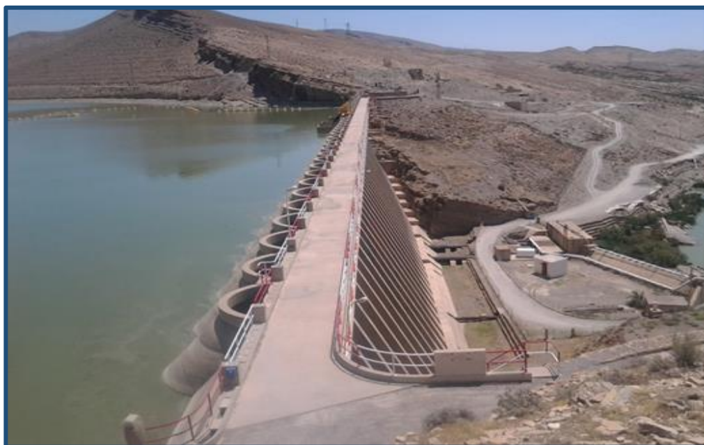
Fig.II.05. La digue du barrage K'sob.
