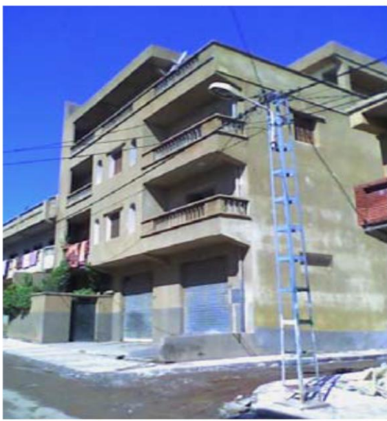
صورة رقم 17: تموضع العمود الكهربائي
