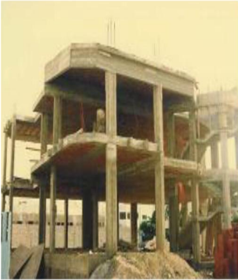
صورة رقم 26: نظام البناء " الهيكل الخرساني "
