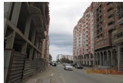
Photo N°43 : voie tertiaire au niveau du secteur 7
