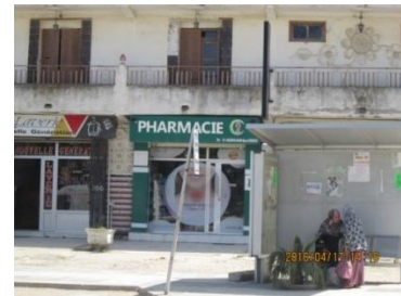
Photo N°60 : signalisation arrêt de bus en mauvaise état
