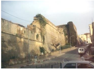
Photo N°07 : Le fort de la casbah
