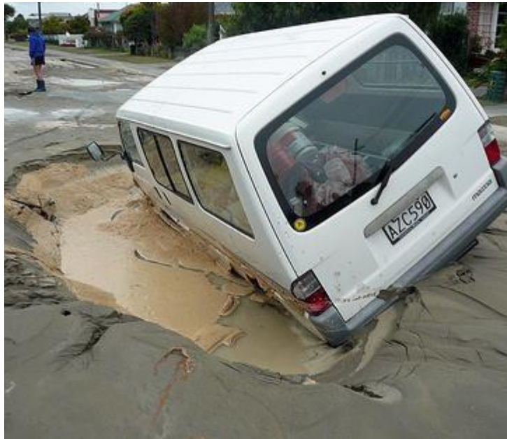
Figure 1.31 : Une camionnette qui malheureusement conduit dans un trou causé par la liquéfaction, du Nord de New Brighton, lors du séisme de Christchurch (2011)
