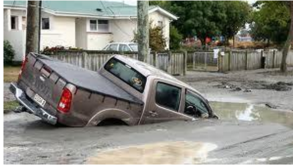
Figure 1.32 : Un véhicule enlisé dans la liquéfaction, après le tremblement de terre à Christchurch, New Zealand (2011)
