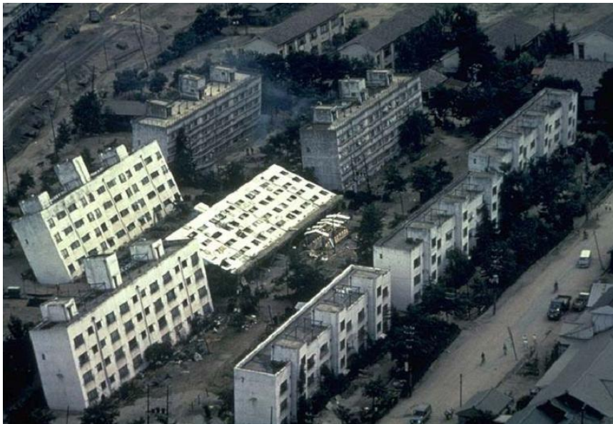
Figure 1.10 : Inclinaison des bâtiments d'appartements de Kawagishi-cho à Niigata au Japon dues à la chute de la capacité portante du sol par liquéfaction (d'après Peter M. Byrne et al, 2008).
