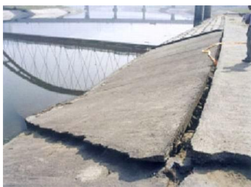
Figure 1.22 : Endommagement de bâtisses dû à la liquéfaction en Taïwan (d'après Dr Hsein, 2002).
