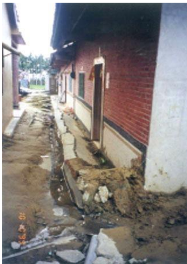
Figure 1.20 : Ebullition de sable dans un quartier résidentiel au Comté de Zhanghua (d'après Dr Hsein, 2002).
