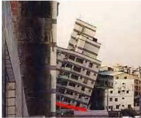
Figure 1.24 Bâtiments renversés à TAIWAN en 1999 (d'après Boua Bilal et Boudrouaz Djamel Eddine 2007)
