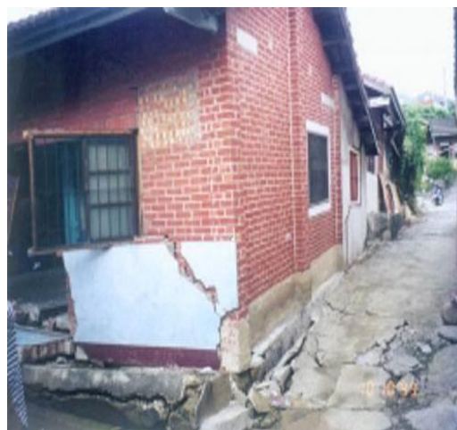
Figure 1.22 : Endommagement de bâtisses dû à la liquéfaction en Taïwan (d'après Dr Hsein, 2002).
