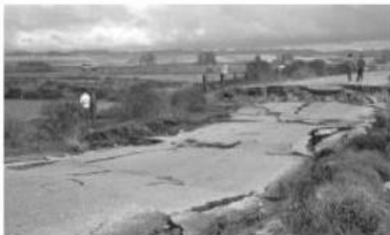
Figure 1.14 : Epandage latéral le long de la route Sandholdt (à gauche) et destruction d'un centre de recherche (à droite) à Moss Landing. (D'après le Earthquake Engineering Research Center, University of California, Berkeley; Elgamal et al, 2001)
