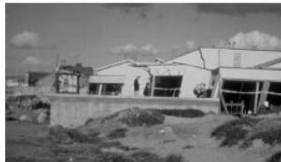
Figure 1.14 : Epandage latéral le long de la route Sandholdt (à gauche) et destruction d'un centre de recherche (à droite) à Moss Landing. (D'après le Earthquake Engineering Research Center, University of California, Berkeley; Elgamal et al, 2001)
