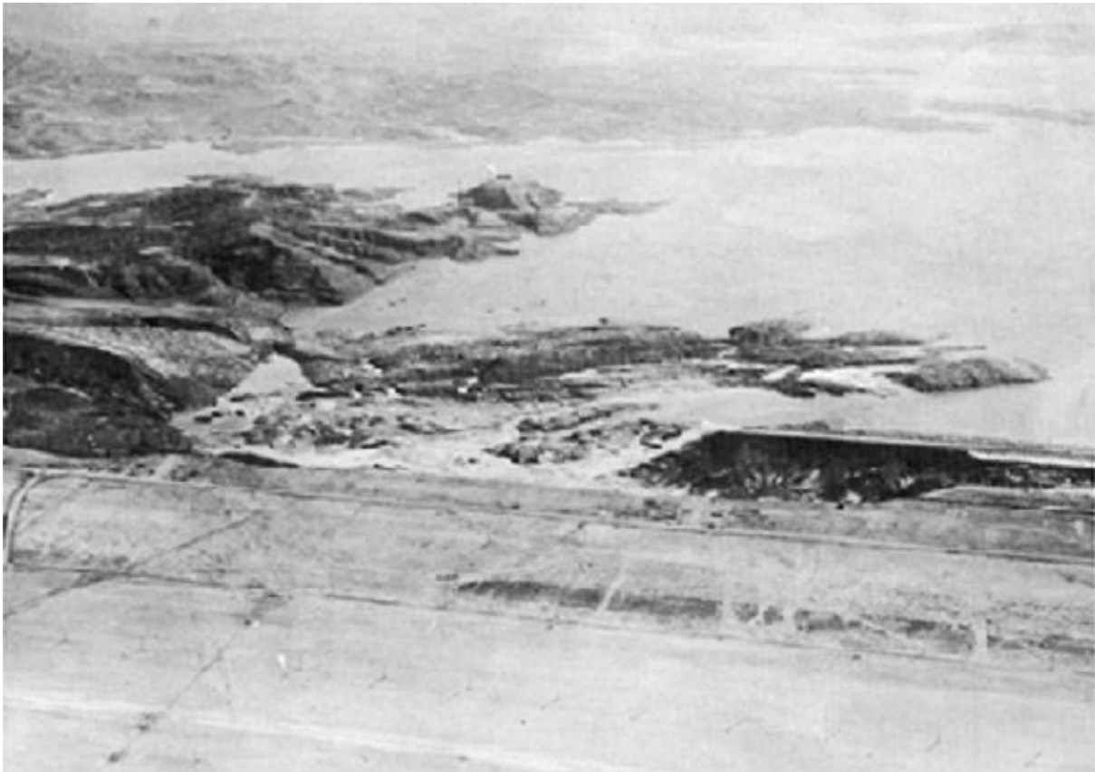
Figure 1.9 vue aérienne de la rupture de barrage de Fort Peck (corps de l'armée des États-Unis d'Ingénieurs, 1939, d'après Mike Jefferies et Ken Been, 2006)
