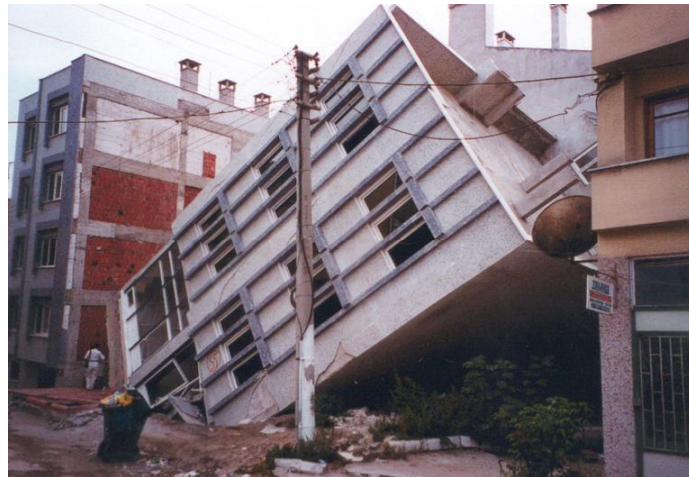
Figure 1.26 Poinçonnement de la fondation sous la liquéfaction sisme Turquie 1999 (d'après Peter M. Byrne et al, 2008).
