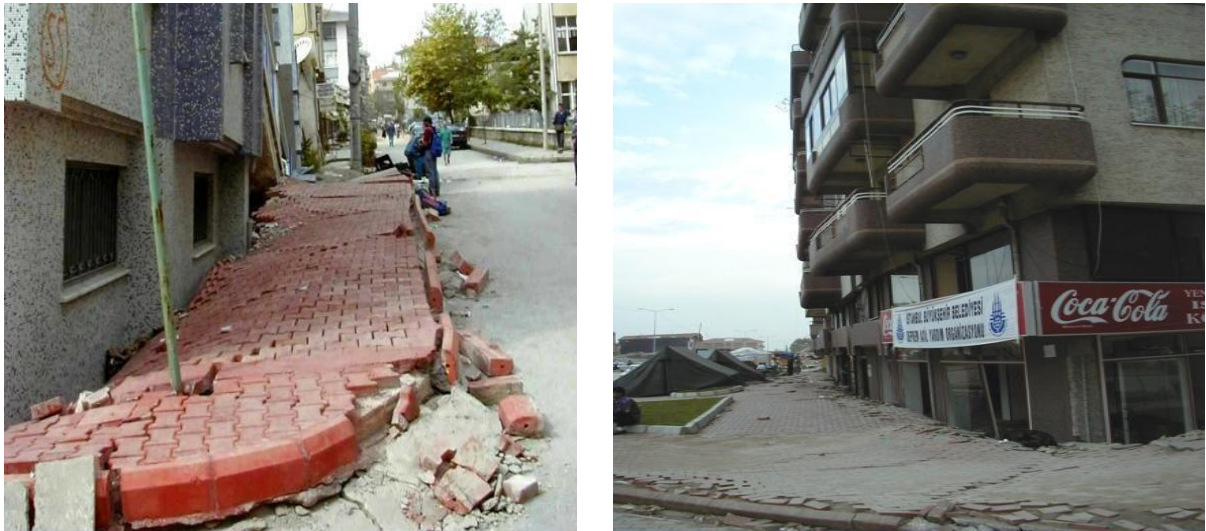
Figure 1.26 Poinçonnement de la fondation sous la liquéfaction sisme Turquie 1999 (d'après Peter M. Byrne et al, 2008).
