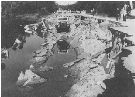
Figure 1.12 rupture de remblai sur le lac Ackermann déclenché par camions de vibroseis (de Hryciw et al, 1990. Photographies avec bonté fournies par prof. R. Hryciw, d'après Mike Jefferies et Ken Been, 2006,)
