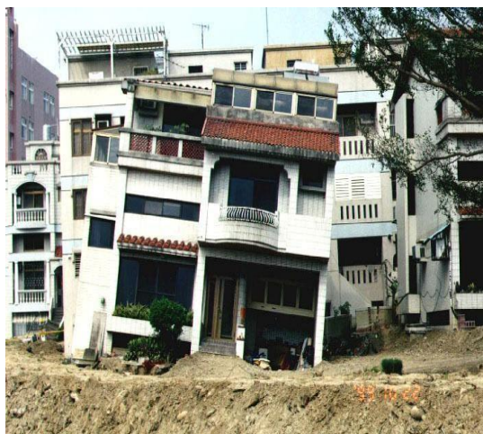
Figure 1.22 : Endommagement de bâtisses dû à la liquéfaction en Taïwan (d'après Dr Hsein, 2002).
