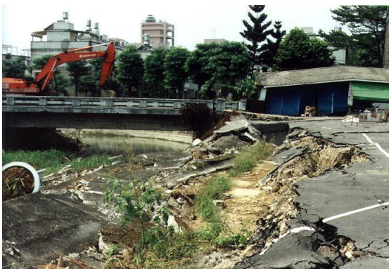
Figure 1.22 : Endommagement de bâtisses dû à la liquéfaction en Taïwan (d'après Dr Hsein, 2002).
