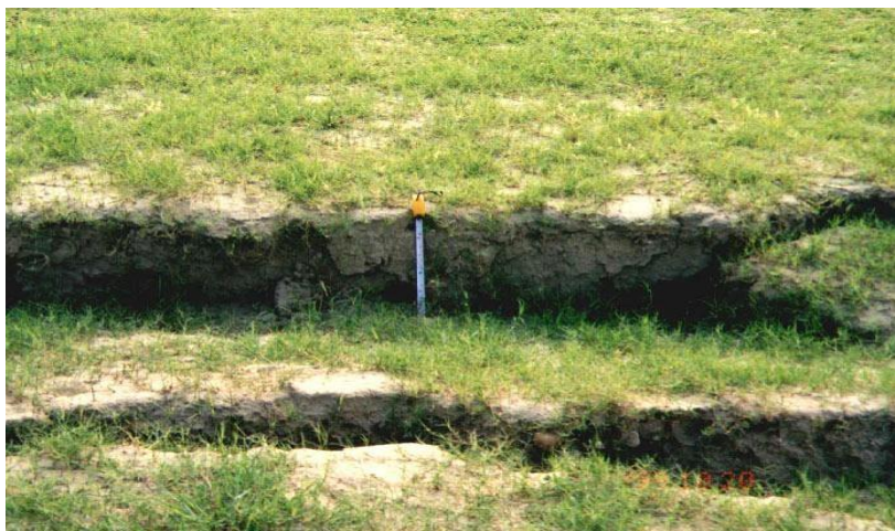
Figure 1.21 : Fissures considérables dans le sol à Nantou (d'après Dr Hsein, 2002).
