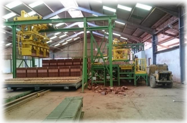
Figure 48: vue de la dépileuse décharge le brique
