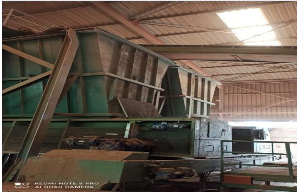
Figure 12 : les silo des stockage
