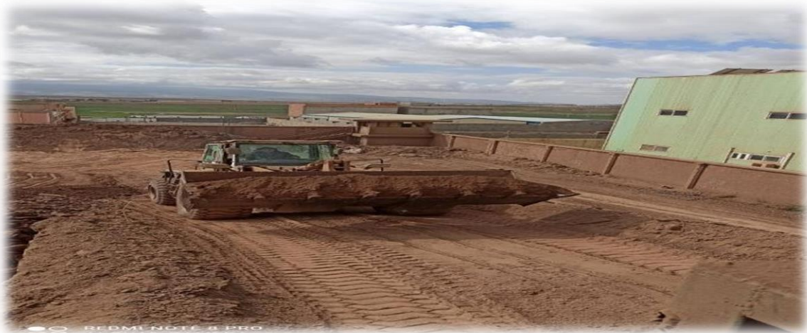
Figure 10: transport de l'argile vers la brise motte
