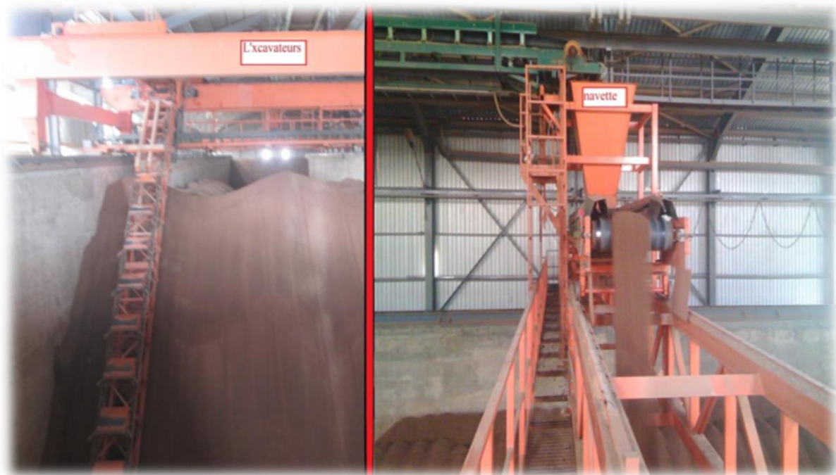
Figure 22 : Excavateur et navette (ALTOMAC)
