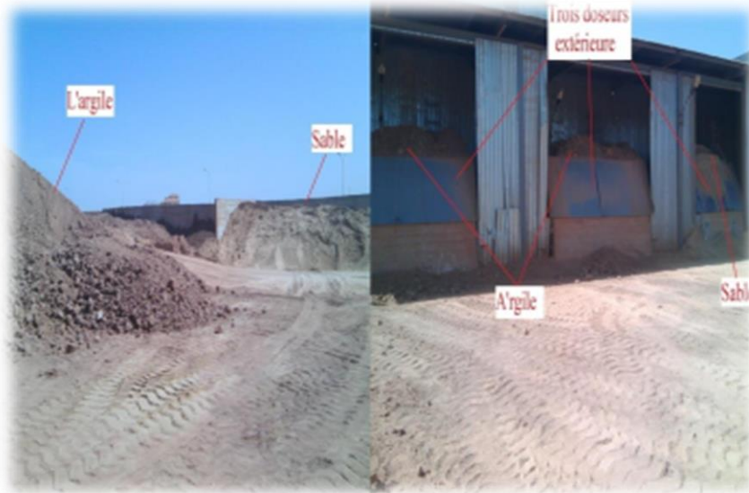
Figure 9: Matière première dans la trémie extérieure.
