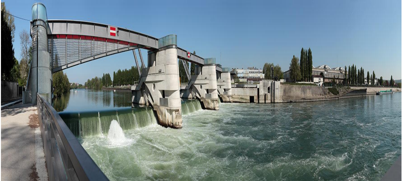
Figure I.5 : Barrage de Chatou-France
