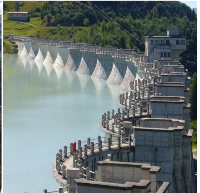
Figure I.9 barrage de la Girotte- multi-voûtes
