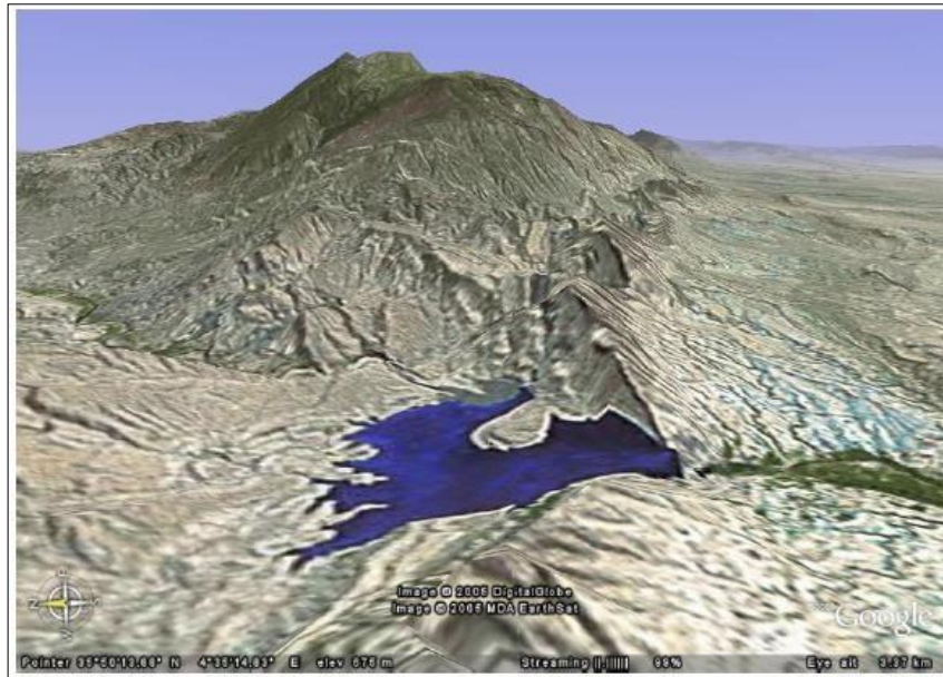
FigureIV.1- Vue aérienne du barrage du K'sob par Google Earth.
