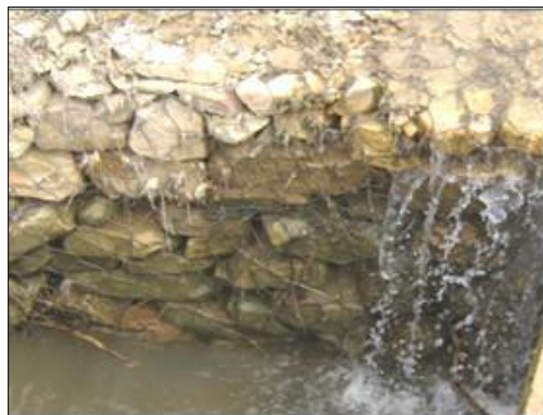
Figure I.3- Seuil de sédimentation en gabions et en pierres sèches [2].
