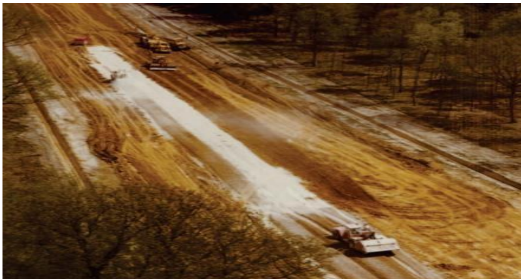
Figure II .1- Traitement de remblai à la chaux (Rossi et al .2007).
