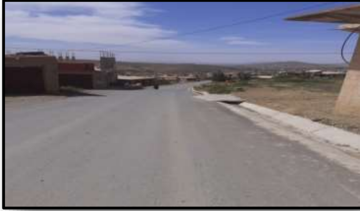
الصورة رقم 35: تأهيل طريق أولاد أمسلم
