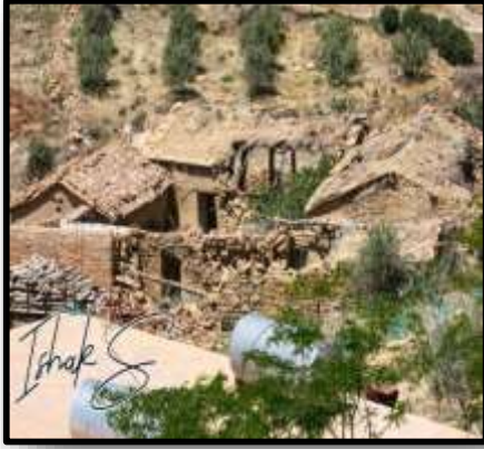
الصورة رقم 15: منزل قديم بالطوب في بلدية ونوغة المصدر: ممثل المجتمع المدني لبلدية ونوغة إسحاق سلماني
