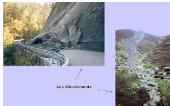
Figure 1.10: Eboulement ou écoulement
