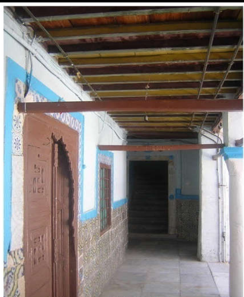
الصورة 29: سقف أروقة الطابق الأرضي
