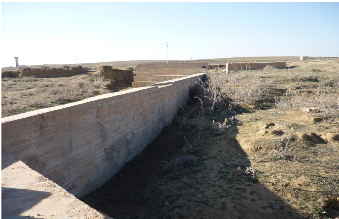
Figure(II.4) coté amont de la digue
