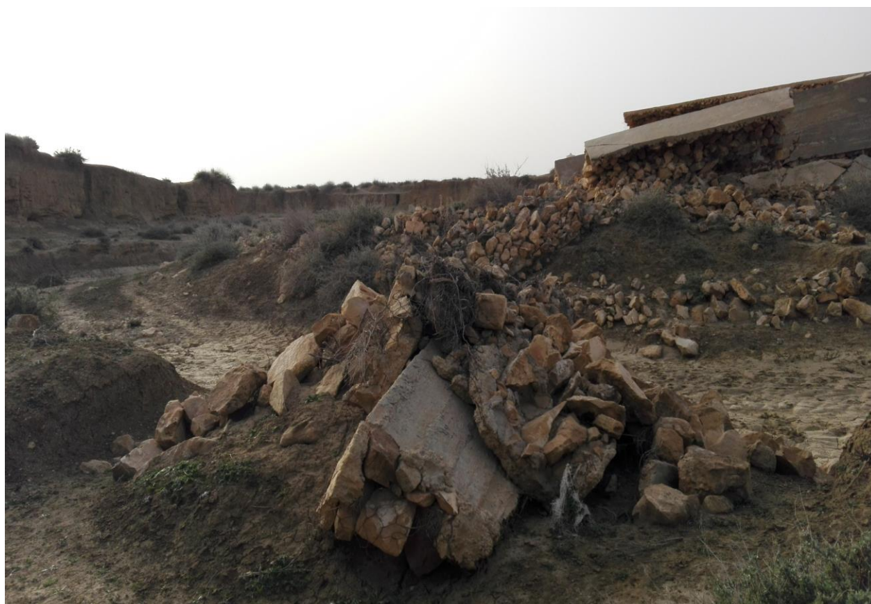
Figure(III.5) Scène montre la disparition de la rive nord du barrage après les inondations
