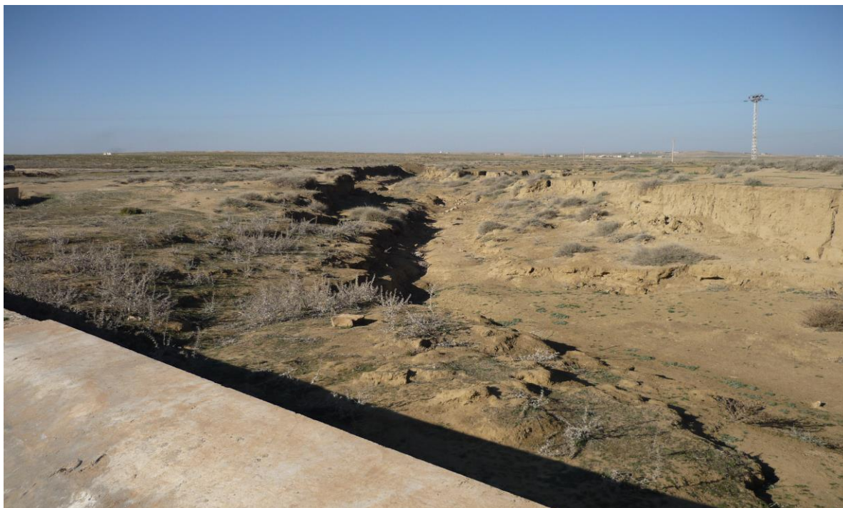
Figure (V.4) Phénomène d'érosion externe de sol des rives d'oued
