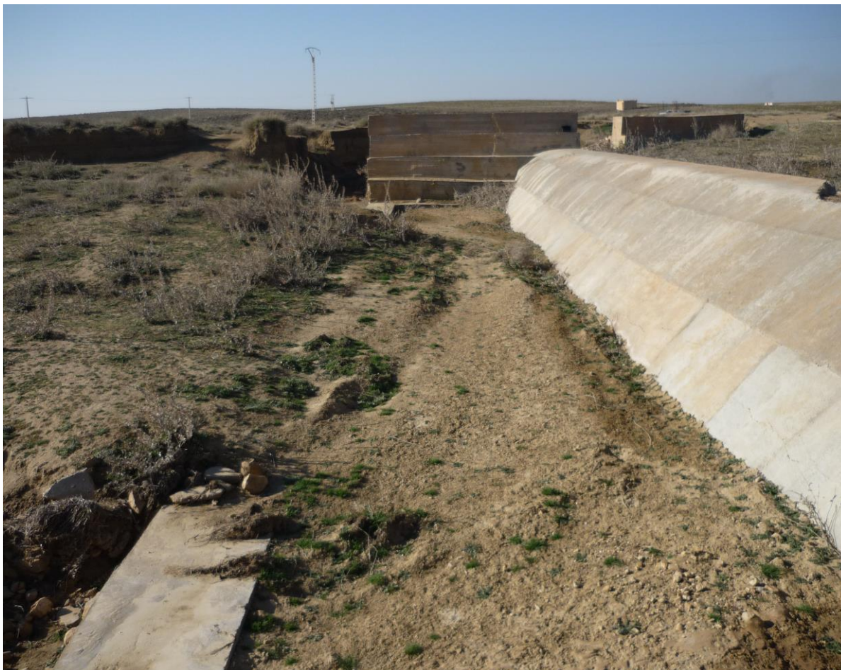
Figure(II.5) coté aval de la digue
