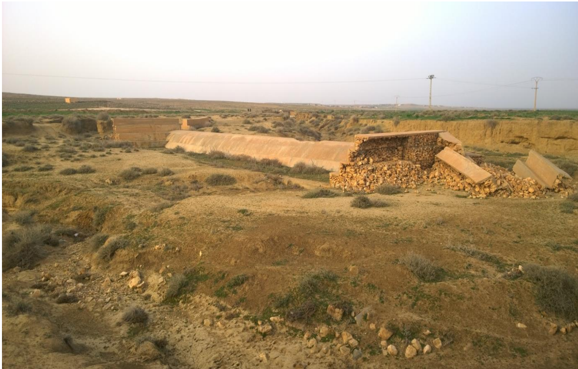
Figure (II.3) Vue générale Digue Ouled Ali ben Daoud( maâch)
