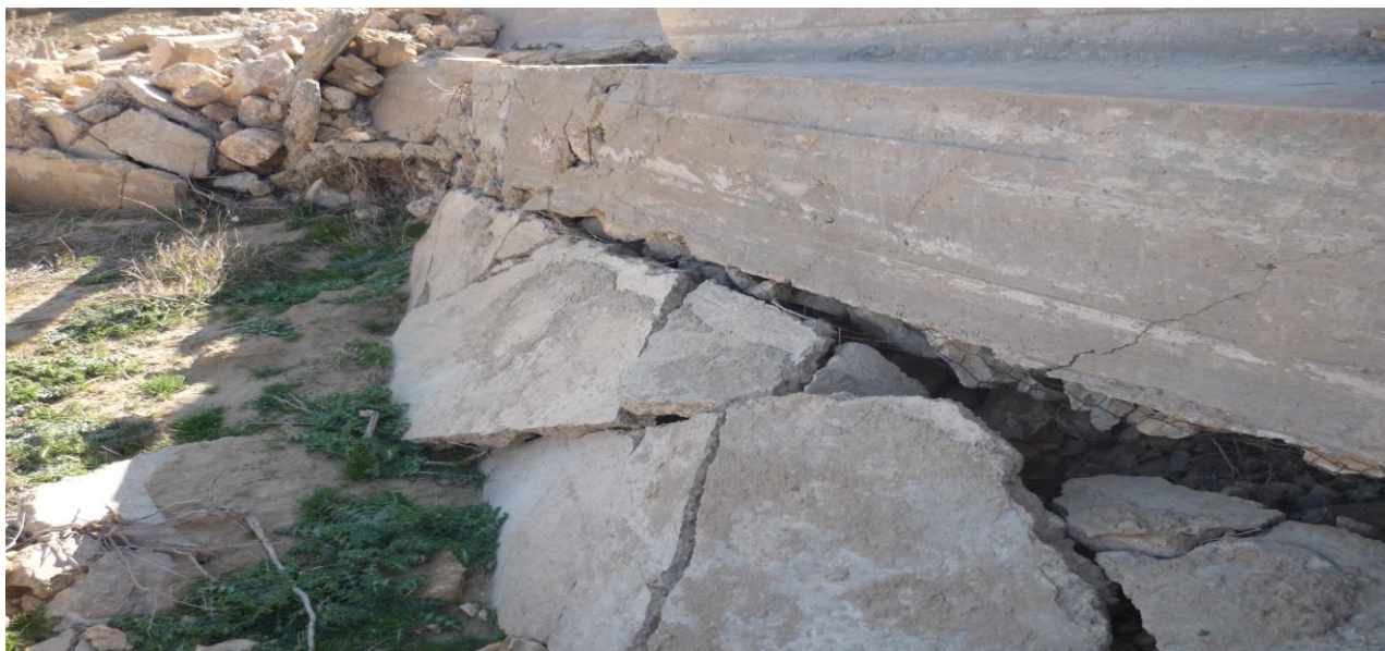
Figure (V.1) Paysage montre La faiblesse de la qualité des matériaux utilisés dans la construction
