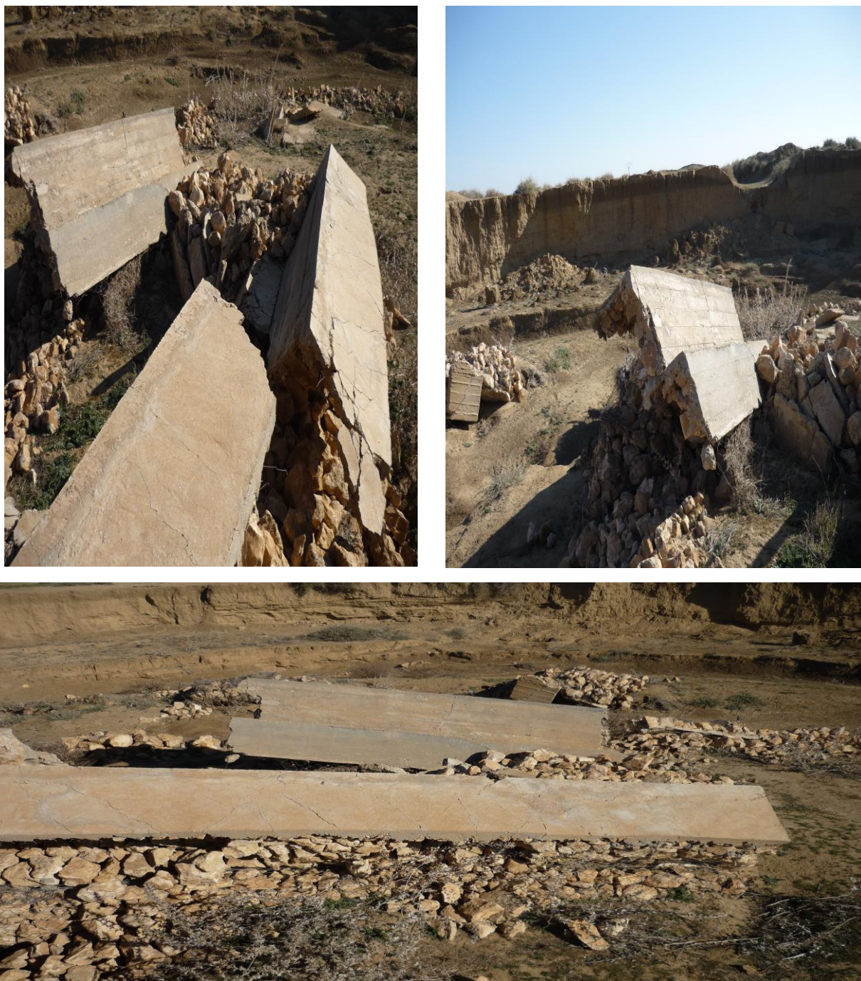
Figure (V.2) Des scènes montrant l'absence des renforcements sur le béton armé
