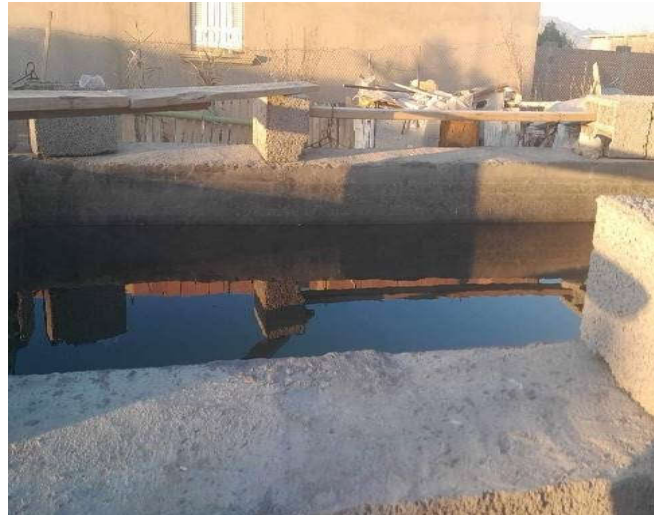
Fig11. Bassin (G02) ( photo personnel).
