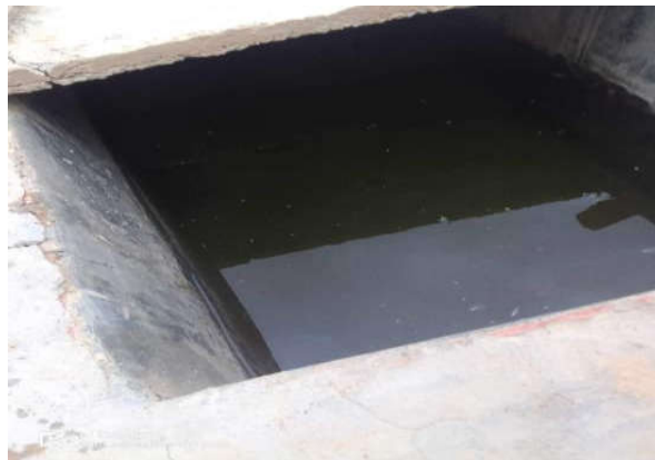
Fig10. Bassin (G01) (photo personnel).
