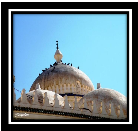
Photo 49 : les coupoles de la zaouïa
