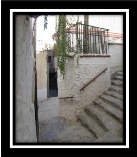
Photo 23: Les escaliers qui mènent vers la porte de la mosquée
