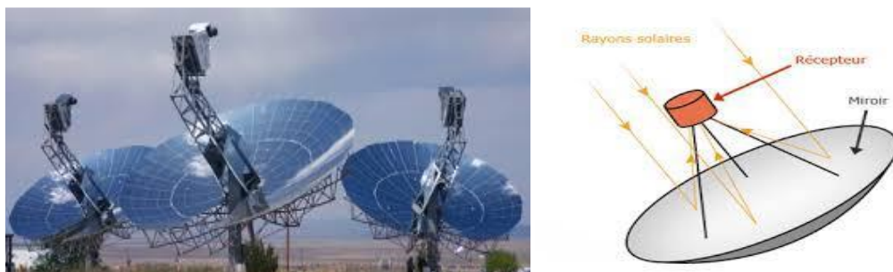
Figure III.4 : centrale thermodynamique parabolique.
