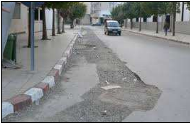
صورة رقم (05) ممهل لا يتطابق مع المعايير صورة رقم (06) طريق لم يتم إعادته إلى حالته
