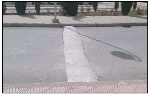
صورة رقم (05) ممهل لا يتطابق مع المعايير صورة رقم (06) طريق لم يتم إعادته إلى حالته
