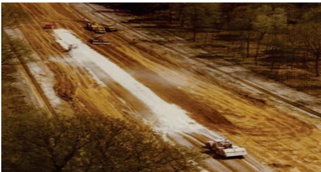
Figure II.1: Traitement de remblai à la chaux (Rossi et al .2007).
