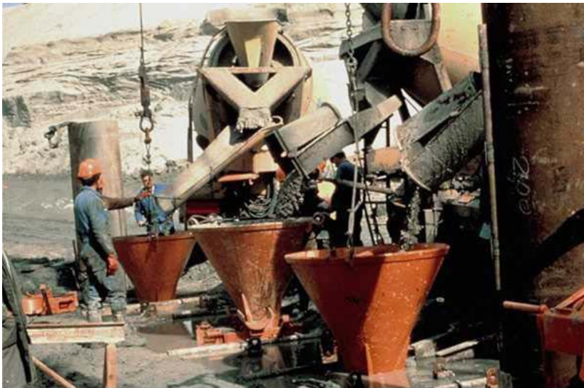
Figure 1.4 Les murs en parois moulées [12].
