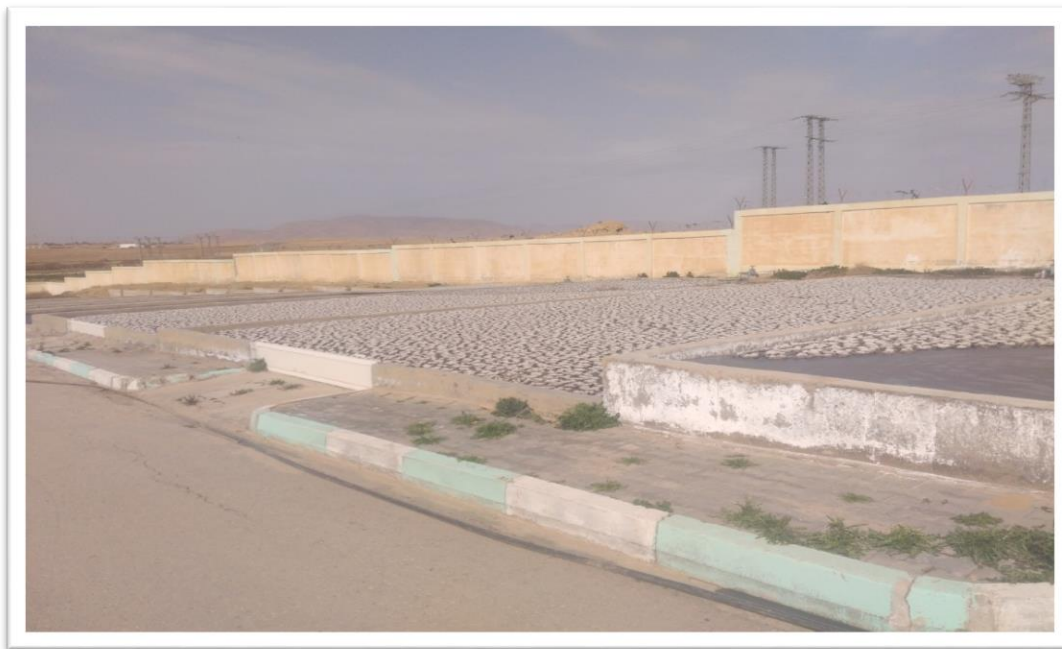
Photo II-10 : Lits de séchage de la STEP de Sidi Aissa
